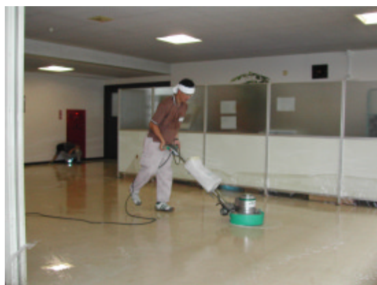
試験施工 剥離剤塗布後の洗浄
